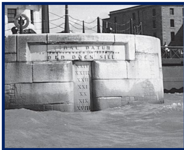
Regla de marea ubicada en Liverpool (Fotografía de Philip Woodworth)
